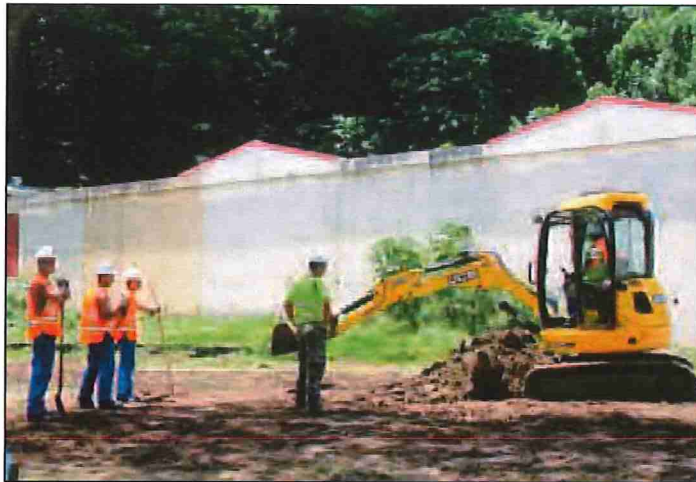
Les jeunes reçoivent des formations qualifiantes. Ici, l'apprentissage de la conduite d'engins.
